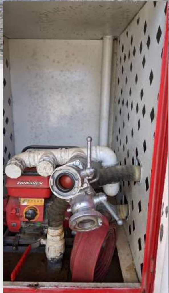
13 Sonderkonstruktion, Verteiler zum Anschluss von deutscher und chinesischer Storz-Kupplungen
